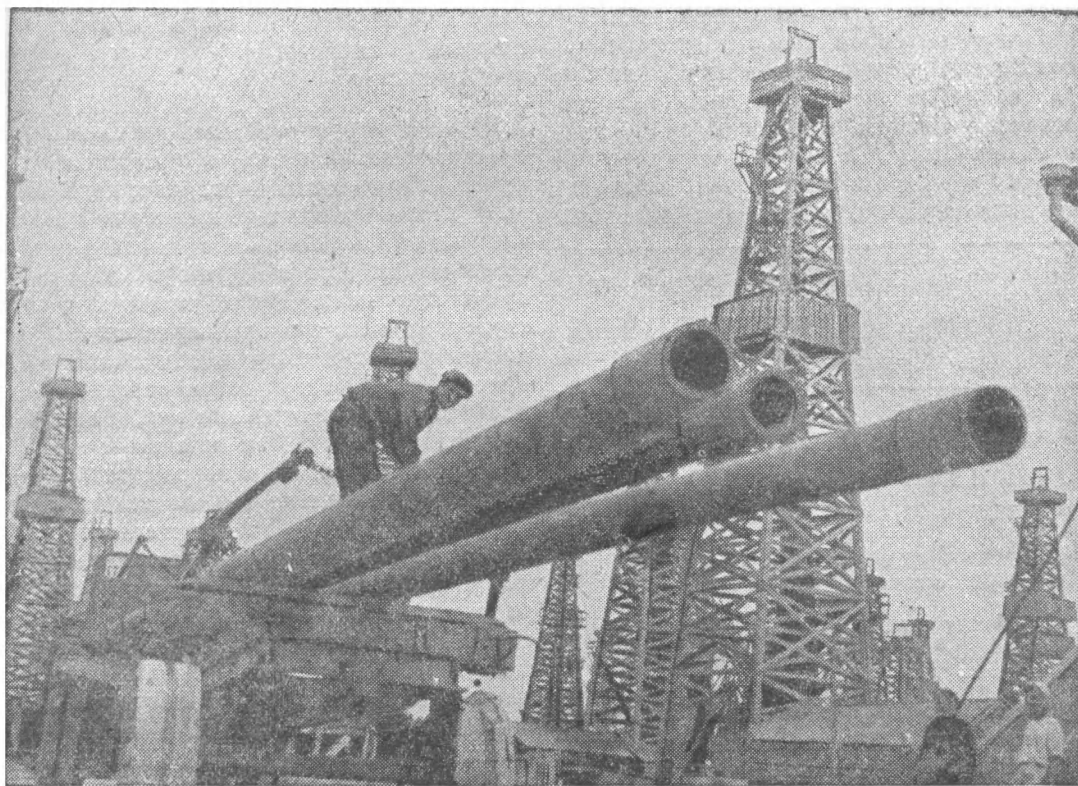
На Сураханских нефтепромыслах—поставка бурильных труб на места новых буровых
