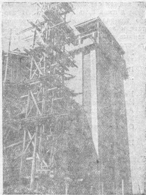
Постройка нового корпуса испытательной лаборатории.
